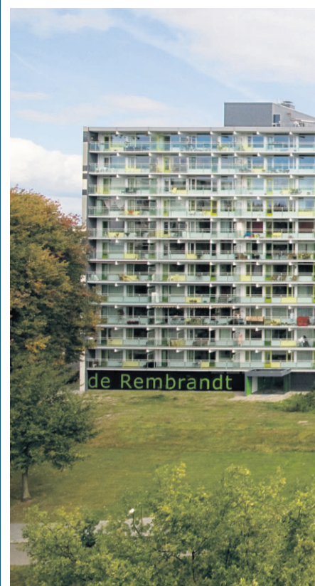
De gerenoveerde Rembrandtflat in Zwolle.
